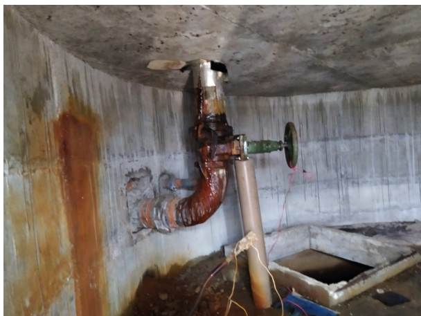
Figura 30: Detalhe da Tubulação de Saída da Câmara Alta do Reservatório GIV.
