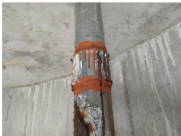
Figura 17: Detalhe da Tubulação de Sucção das Bombas GII.
