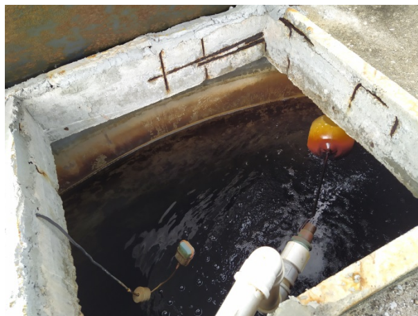
Figura 43: Detalhe da entrada de água tratada na câmara superior do Reservatório GII.
