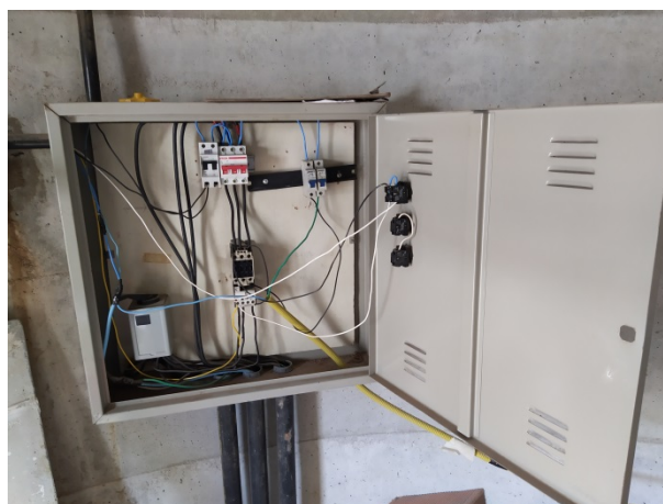
Figura 37: Detalhe do painel de acionamento dos conjuntos moto-bomba do condomínio GII.
