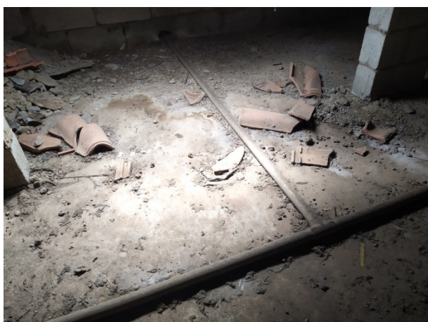
Figura 65: Detalhe da derivação bloco 04 do GII sobre a laje forro no interior do telhado.
