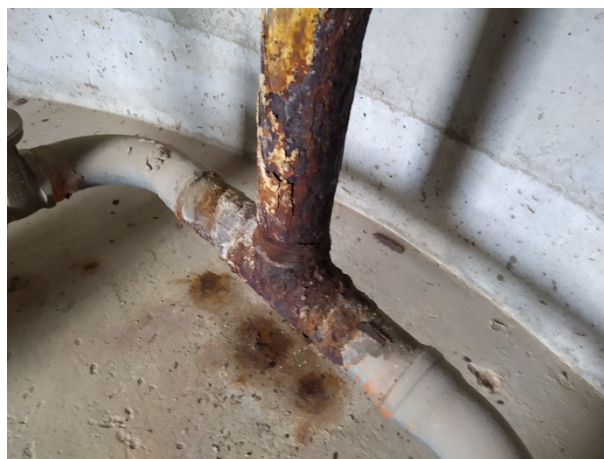
Figura 21: Detalhe da Tubulação de Sucção das Bombas GIII.
