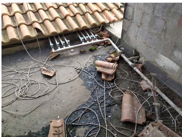
Figura 71: Detalhe da laje sobre o hall das escadarias, com a derivação da tubulação e posterior individualização das ligações (Bloco 04 do GI).
