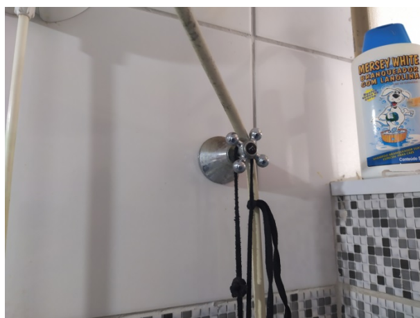
Figura 70: Detalhe do registro geral de 3/4'' localizado abaixo do chuveiro.
