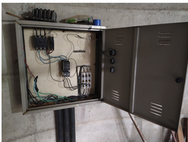
Figura 36: Detalhe do painel de acionamento dos conjuntos moto-bomba do condomínio GI.
