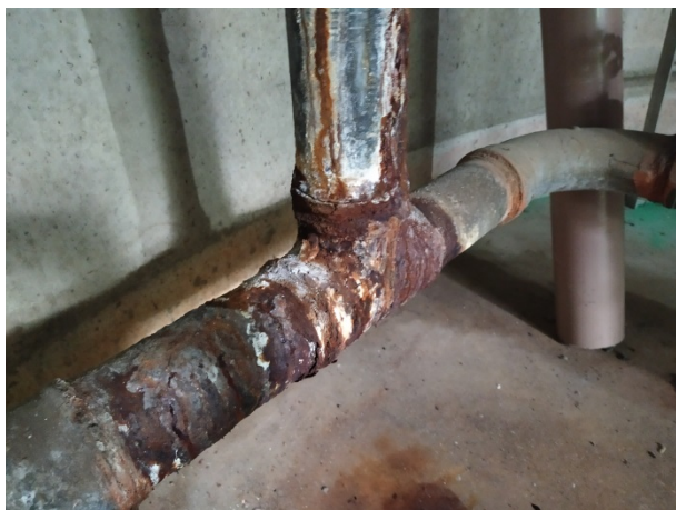
Figura 10: Detalhe da Tubulação de Sucção das Bombas GI.
