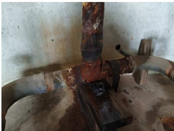
Figura 28: Detalhe da Tubulação de Sucção das Bombas GIV.
