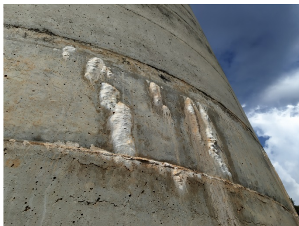
Figura 45: Detalhe do processo de lixiviação evidenciado nas paredes do reservatório GIII.
