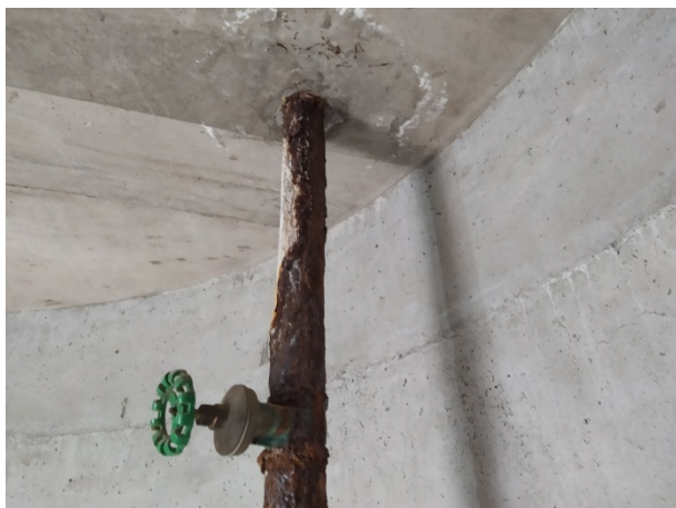
Figura 22: Detalhe da Tubulação de Sucção das Bombas GIII.
