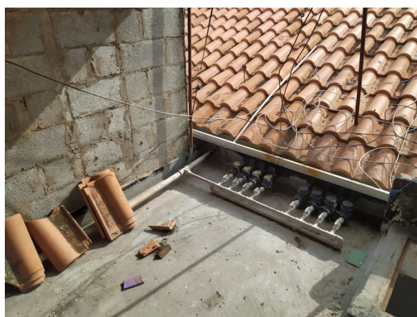
Figura 74: Detalhe da laje sobre o hall das escadarias, com a derivação da tubulação e posterior individualização com hidrometação das ligações (Bloco 06 do GIV).
