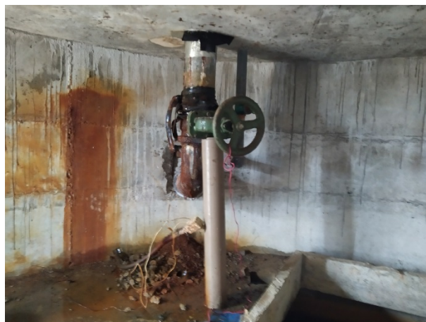
Figura 31: Detalhe da Tubulação de Saída da Câmara Alta Reservatório GIV.
