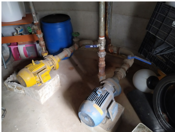
Figura 14: Detalhe dos conjuntos Moto-Bomba GII.
