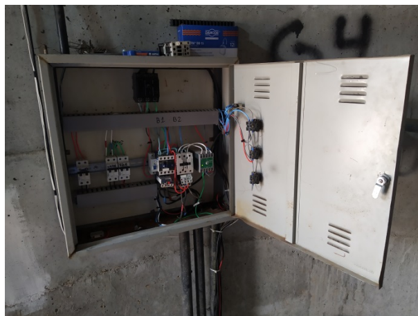
Figura 39: Detalhe do painel de acionamento dos conjuntos moto-bomba do condomínio GIV.
