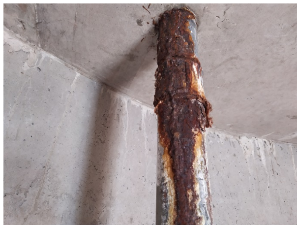
Figura 23: Detalhe da Tubulação de Sucção das Bombas GIII.
