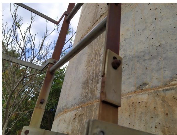
Figura 41: Detalhe do início do processo de corrosão das escadas de acesso do Reservatório GI.
