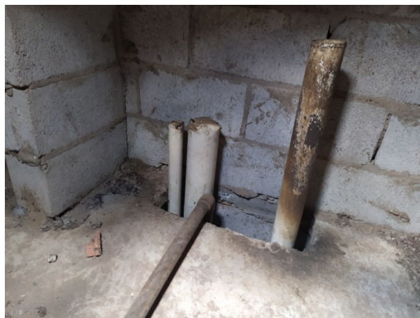
Figura 68: Detalhe da entrada no shaft do bloco 04 do GII.
