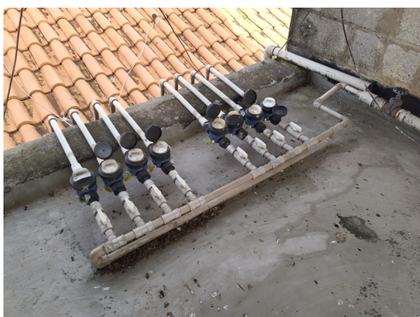
Figura 73: Detalhe da laje sobre o hall das escadarias, com a derivação da tubulação e posterior individualização com hidrometação das ligações (Bloco 06 do GIV).
