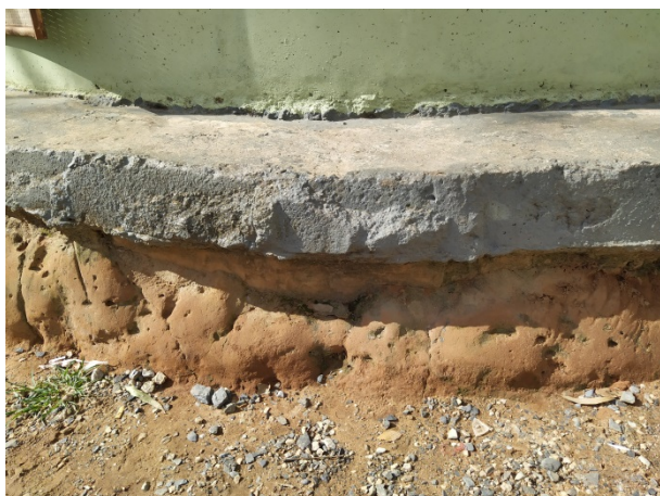
Figura 44: Detalhe da base do reservatório do condomínio GIII.
