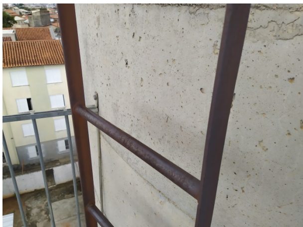
Figura 42: Detalhe do início do processo de corrosão das escadas de acesso do Reservatório GII.
