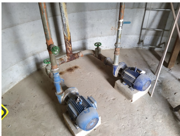
Figura 20: Detalhe dos conjuntos Moto-Bomba GIII.
