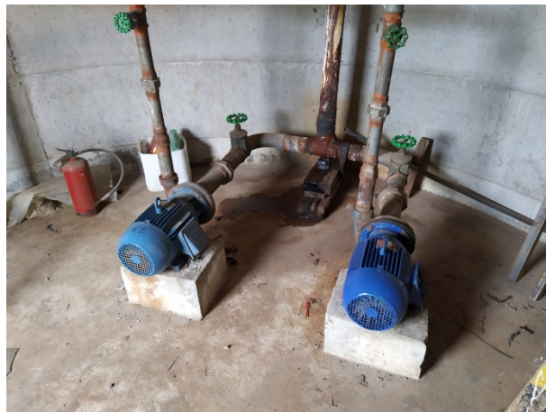
Figura 27: Detalhe dos conjuntos Moto-Bomba GIV.
