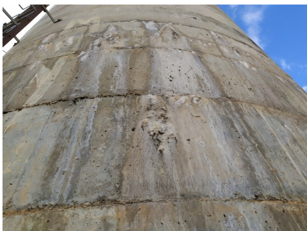
Figura 40: Detalhe do processo de lixiviação evidenciado nas paredes do reservatório GI.
