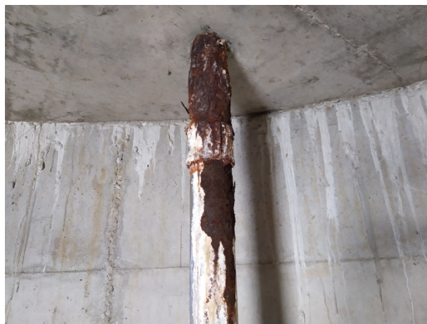
Figura 29: Detalhe da Tubulação de Sucção das Bombas GIV.
