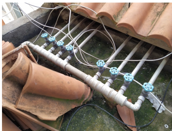
Figura 72: Detalhe da laje sobre o hall das escadarias, com a derivação da tubulação e posterior individualização das ligações (Bloco 04 do GI).
