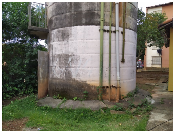
Figura 07: Detalhe das Tubulações do Reservatório GI.
