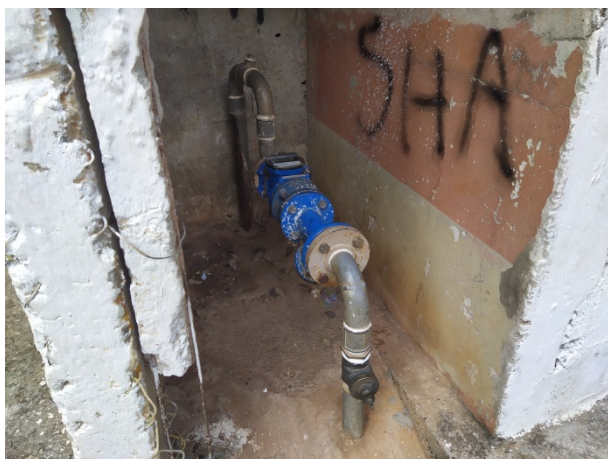
Figura 32: Detalhe do macromedidor condomínio GI.
