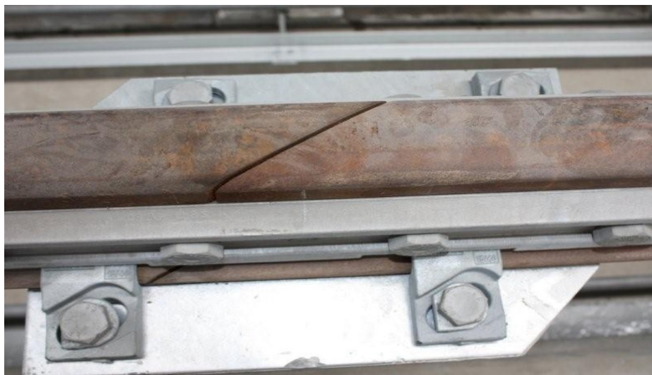
Figura 4 - Fixação dos trilhos nas emendas (notar corte a 45°).
