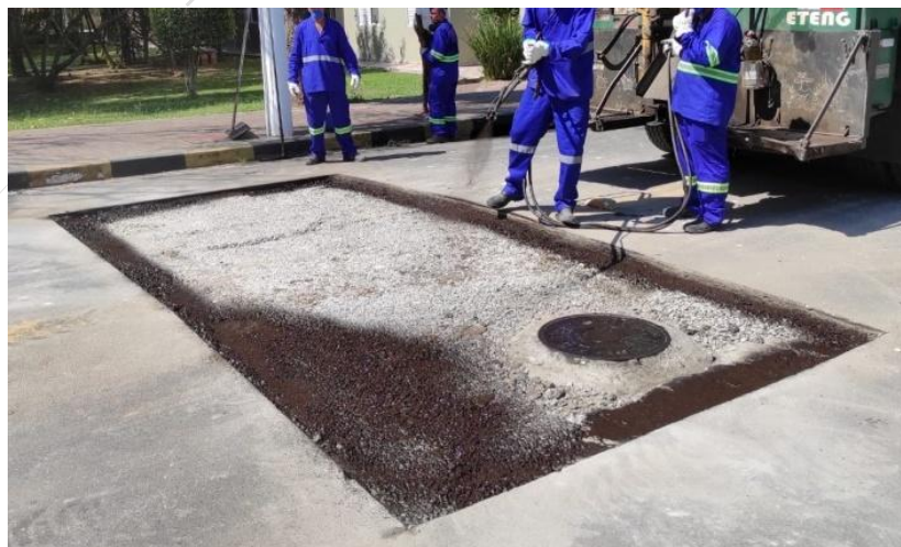
Aplicação da pintura de ligação através da caneta espargidora.
