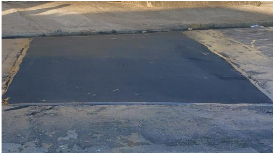
Acabamento nivelado entre o reparo e o pavimento existente.
