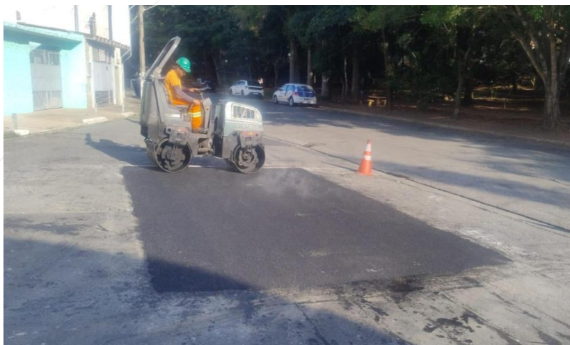
Compactação da massa no sentido transversal.
