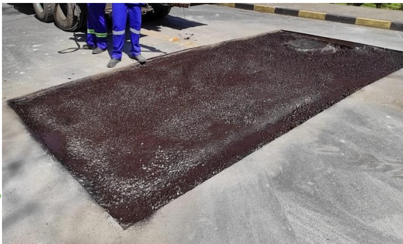
Pintura de ligação aplicada de forma uniforme em toda a área da caixa.
