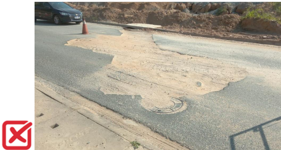
Corte não realizado de forma retilínea.
