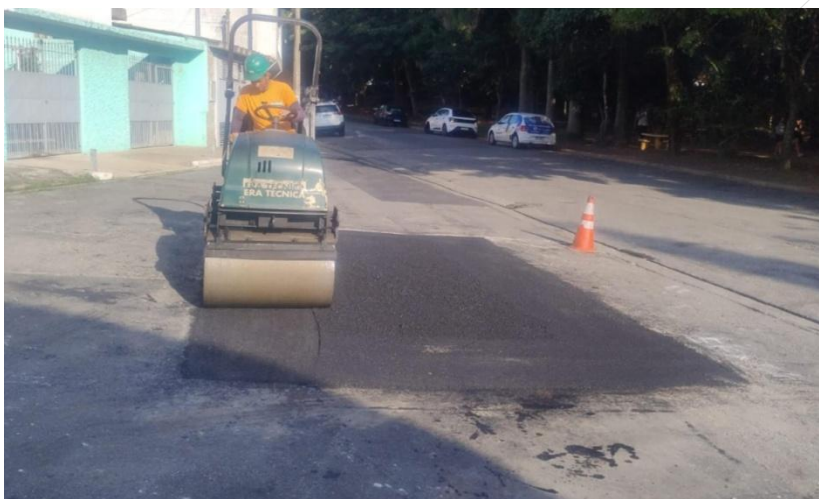
Compactação da massa no sentido longitudinal.
