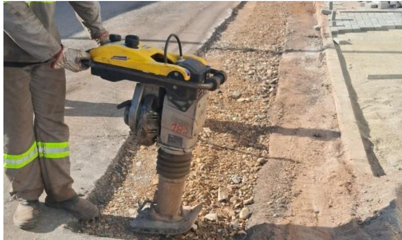
Compactação da vala.
