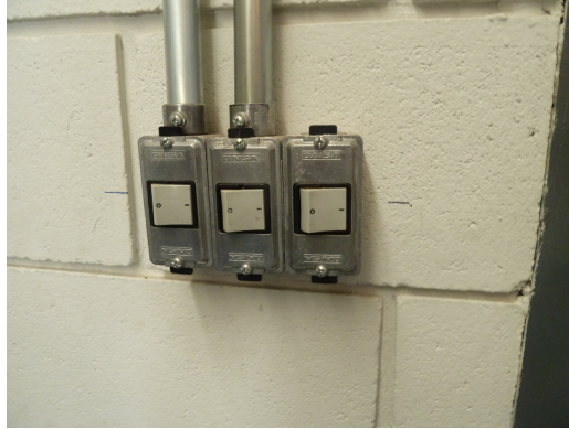
exemplo instalação de interruptor
