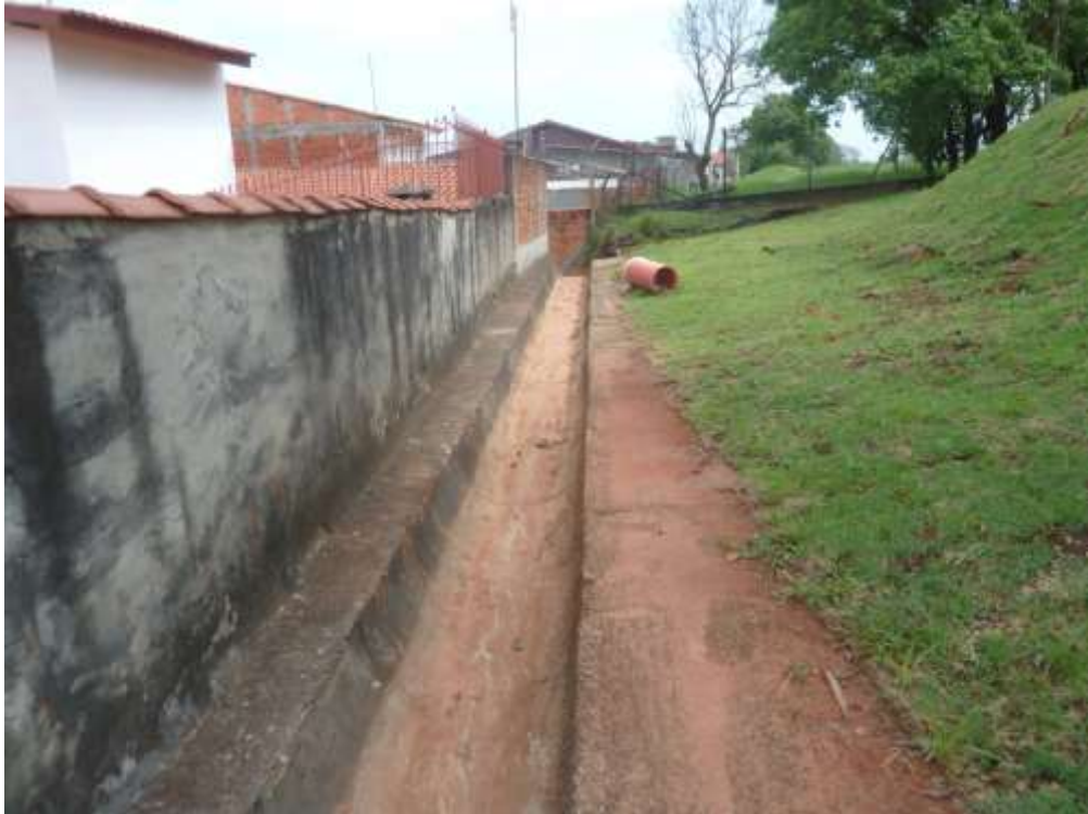
Vista dos fundos sentido ao local do muro de arrimo
