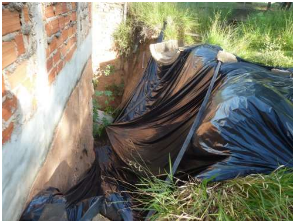
Vista do local do muro de arrimo coberto com lona
