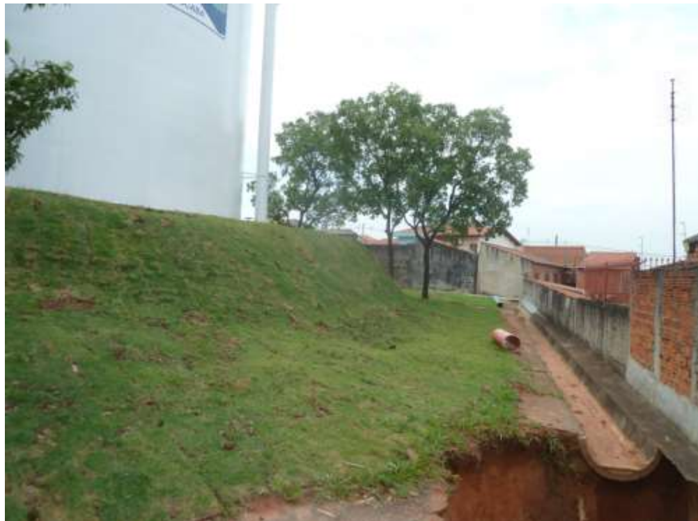
Vista dos fundos sentido oposto ao muro de arrimo
